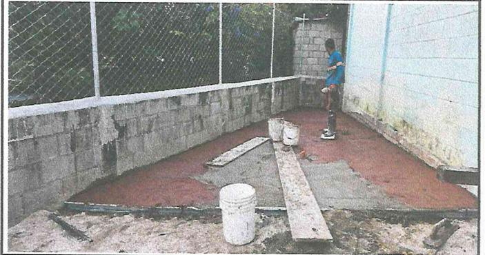
Foto 2: FUNDICIÓN DE LOSA DE PATIO
